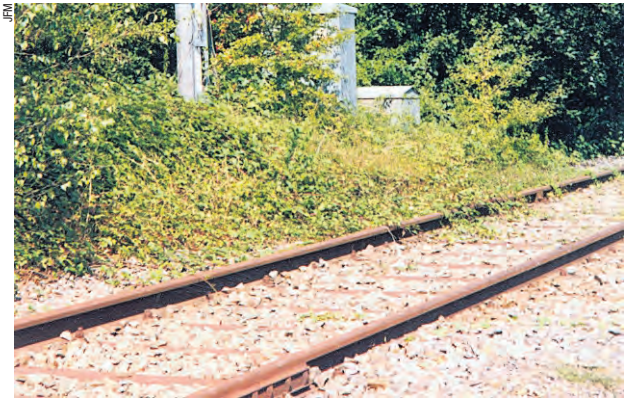
Il manque 12 millions d'euros pour que des trains puissent à nouveau circuler entre Delle et Belfort.
