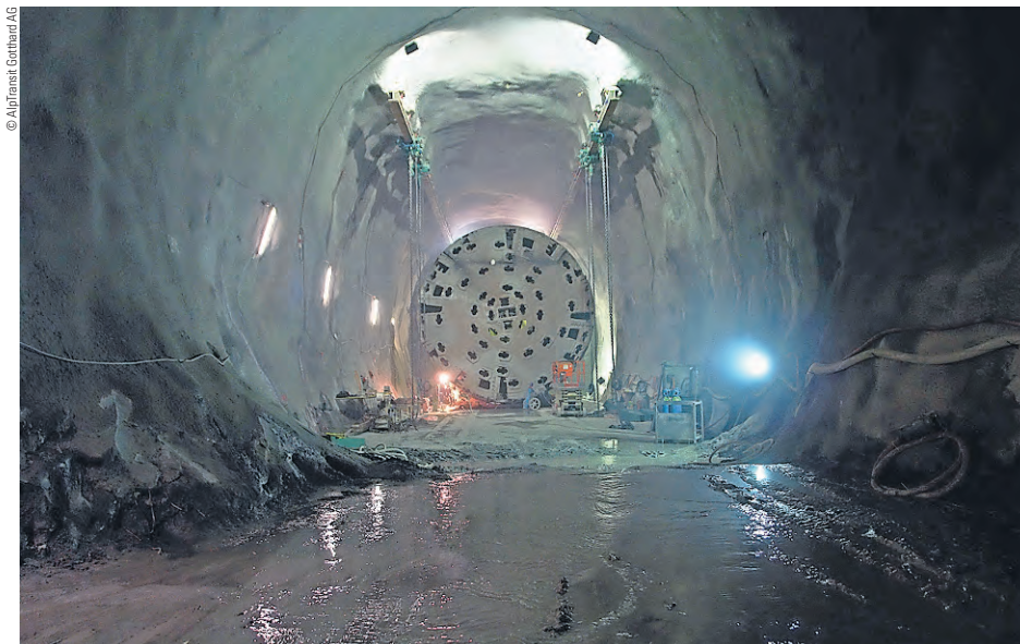
Secondo il SEV, l'apertura della galleria di base del San Gottardo, di cui vediamo qui il cantiere sotto Sedrun, sarà una risposta decisiva alle necessità di sostenibilità del trasporto merci in transito.
