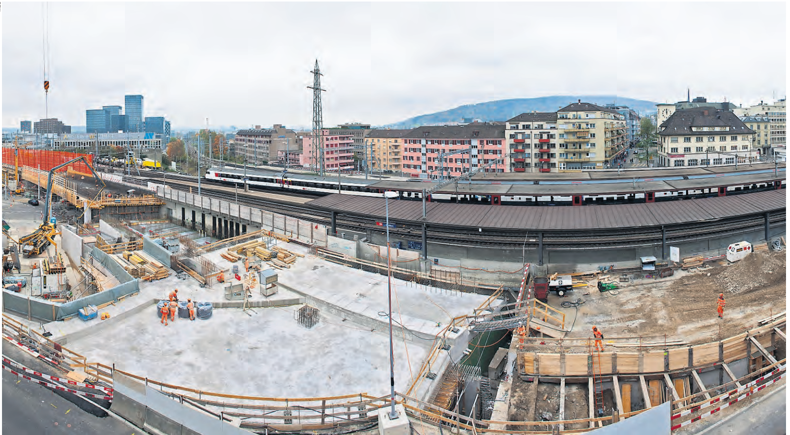
Hier wird an der Durchmesserlinie Zürich gebaut.
