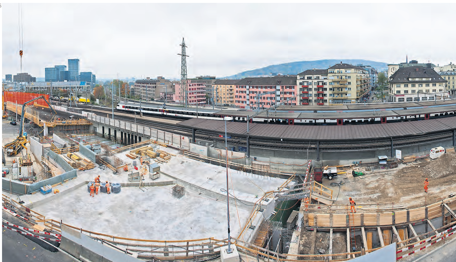
Le chantier de la ligne diamétrale à Zurich, un des projets d'agglomération lancés par les CFF.
