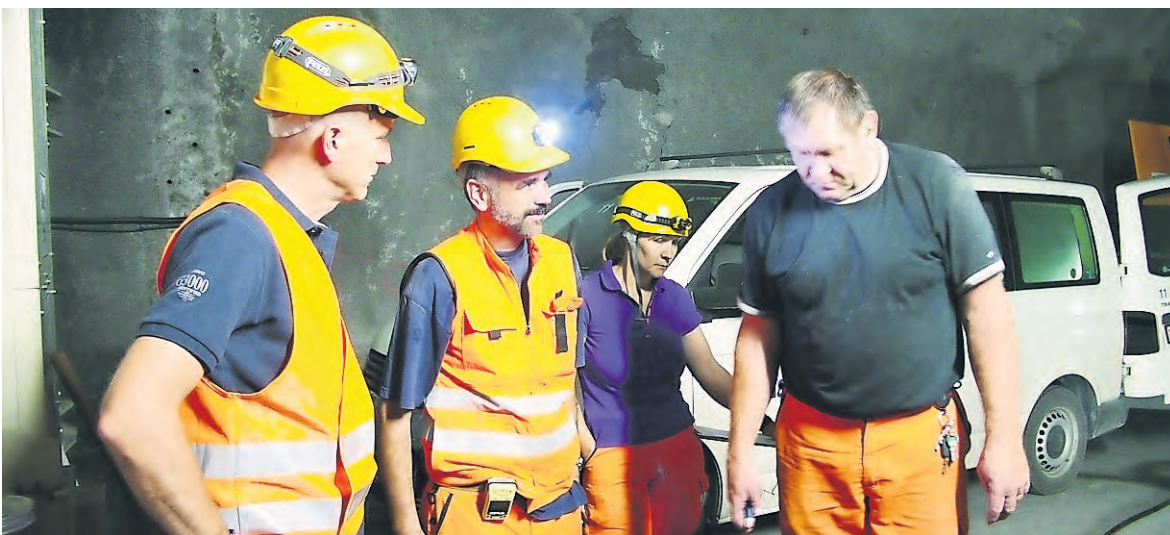
Una squadra tecnica al lavoro sotto il Lötschberg.
