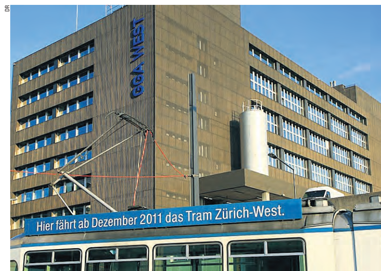
La nuova linea di tram Zürich-West è costata 320 milioni di franchi.
