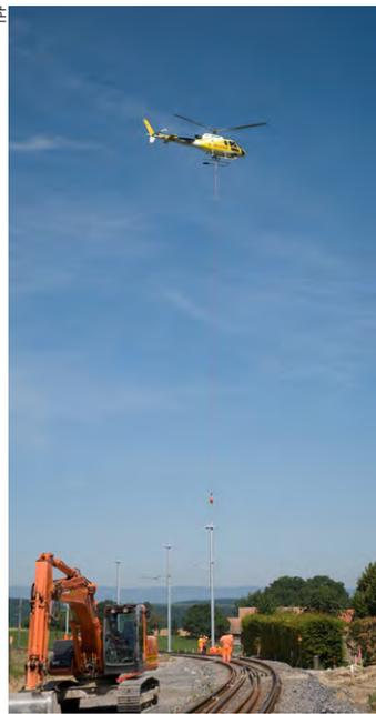
Les nouveaux mâts de support pour les lignes de contact sont amenés par les airs à l'endroit exact où ils doivent être implantés.
