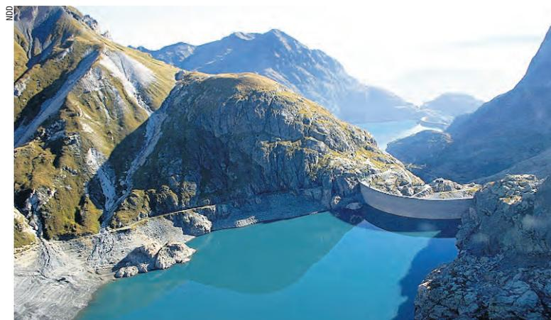
L'eau sera pompée depuis le barrage d'Emosson (à l'arrière-plan) vers le barrage du Vieux Emosson (ci-devant) dont la digue sera rehaussée d'une vingtaine de mètres pour augmenter sa capacité de stockage. Aux heures de pointe, l'eau sera turbinée via un puits vertical dans une cavité creusée à 535 mètres sous la montagne. Le nom Nant de Drance provient du cours d'eau qui coule entre les deux barrages.
