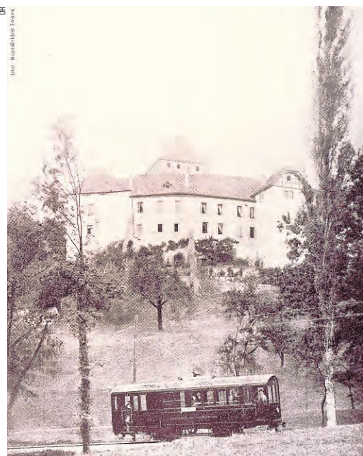
Chemins de fer électriques Veveysans sous le château de Blonay.
