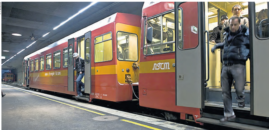
La gare souterraine du NStCM à Nyon a été l'un des principaux chantiers ferroviaires vaudois de cette dernière décennie.
