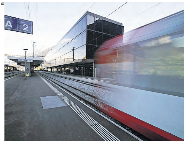
Adeguare le strutture all'aumento di traffico richiede risorse ingenti.
