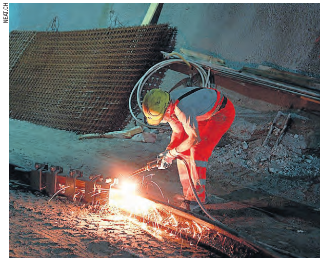
Cantiere Alptransit di Faido.
