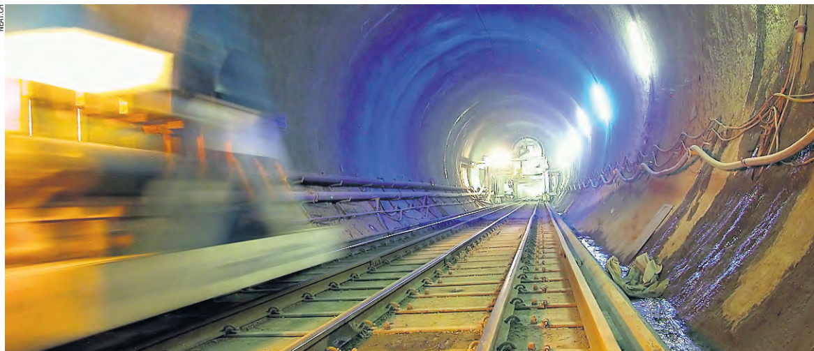
Il cantiere Alptransit di Bodio.
