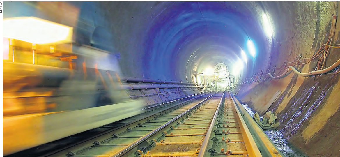
On n'a pas attendu le percement du tunnel pour commencer à installer l'infrastructure ferroviaire.
