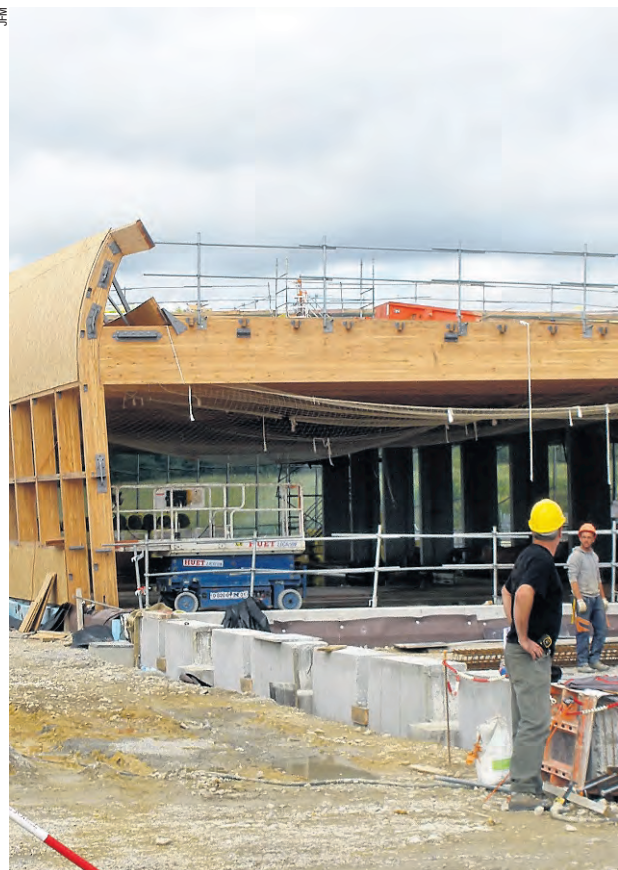
Dans un peu plus d'une année, la gare TGV de Belfort sera terminée.
