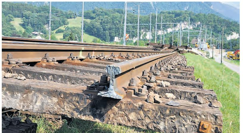
Les CFF troquent de plus en plus les vieilles traverses en bois contre des traverses en béton.
