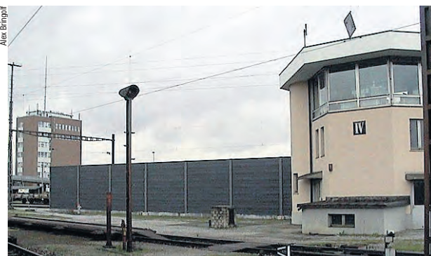
La cabina centrale (a sinistra) e la cabina 4, all'interno della quale sono state scattate le altre foto e che sarà probabilmente utilizzata per comandare le selle di lancio
