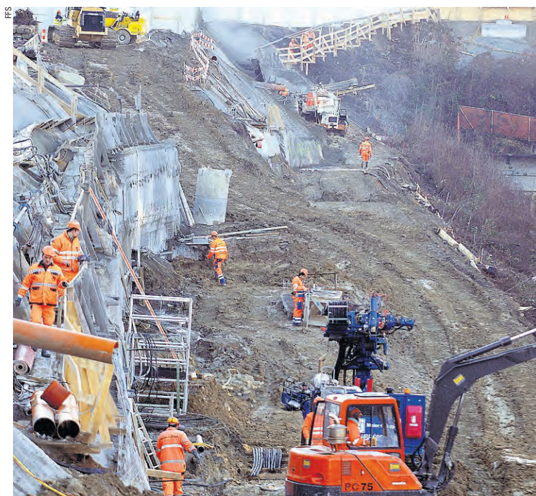
In cantiere il futuro di molti impiegati della Divisione infrastruttura (Durchmesserlinie Zurigo).
