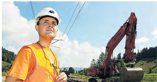
Les agents de sécurité issus du domaine « protection des chantiers » sont syndiqués au SEV dans la section SBV-Securitrans.
