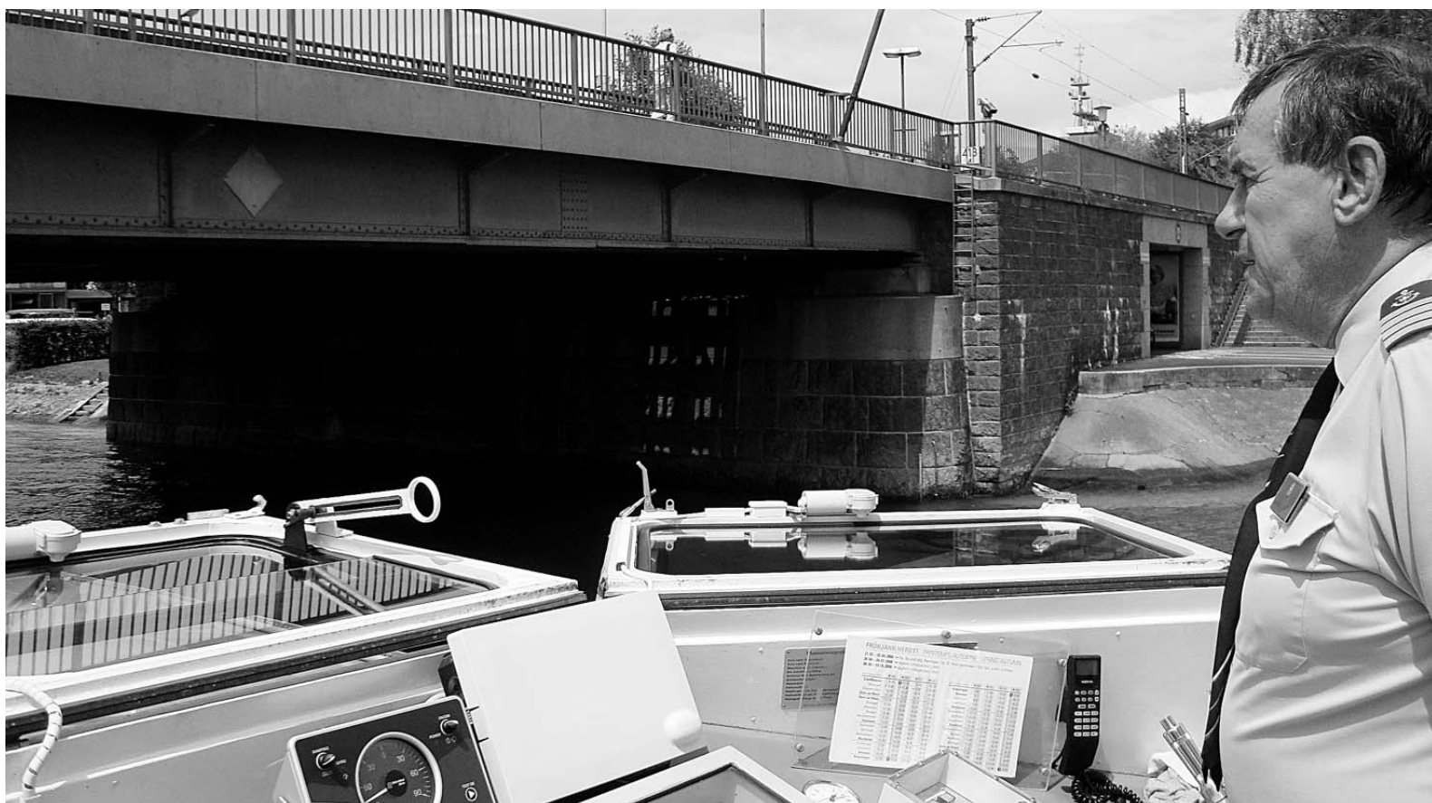
Il ponte sul Reno scorre poco sopra le teste.
