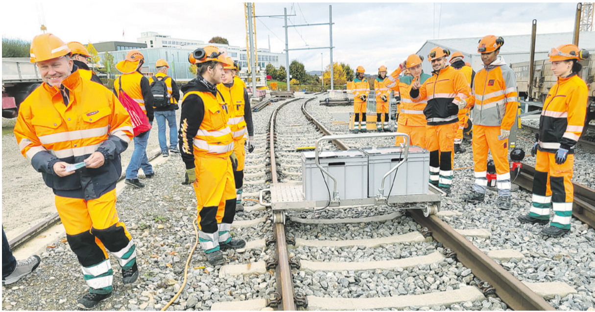
Gleisbaulernende auf der Ausbildungsanlage der BFS Verkehrswegbauer in Sursee.
