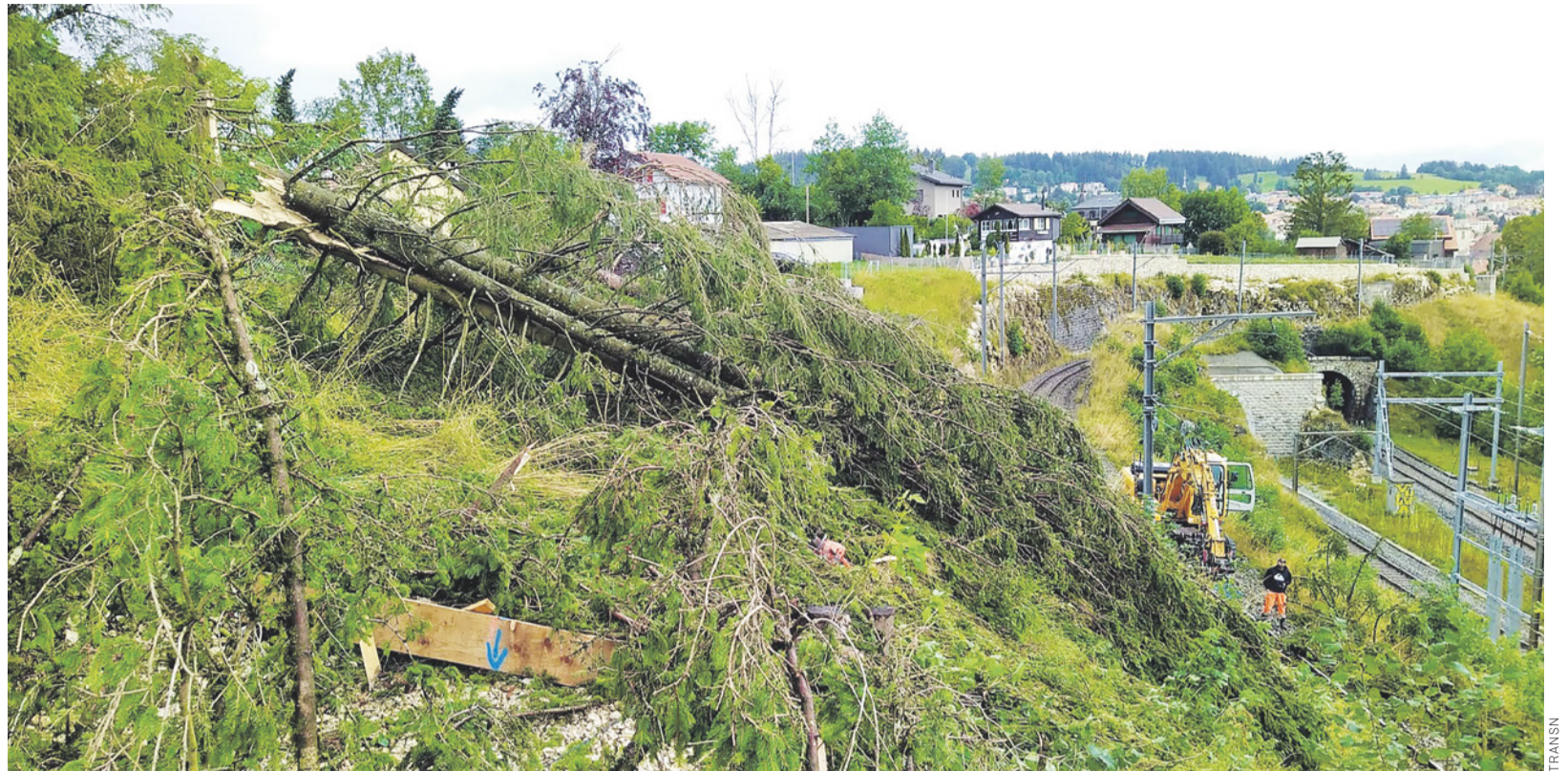
Tant les bus que les trains TransN, ici à gauche la voie de la ligne La Chaux-de-Fonds – Les Ponts-de-Martel, ont été très touchés par la tempête.
