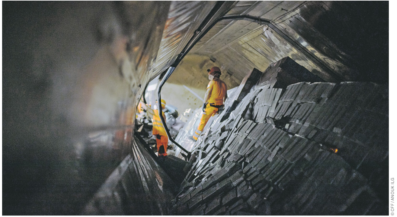
Travailler dans un tunnel par 40 degrés est un effort physique important.
