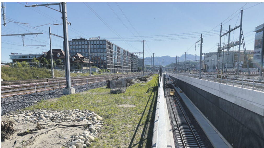
Bahninfrastruktur: Der zunehmende Verkehr macht z.B. in Bahnknoten wie im Berner Wylerfeld Entflechtungen nötig. Hier die Zufahrt zum Tunnel, der im September 2022 eröffnet wurde.
