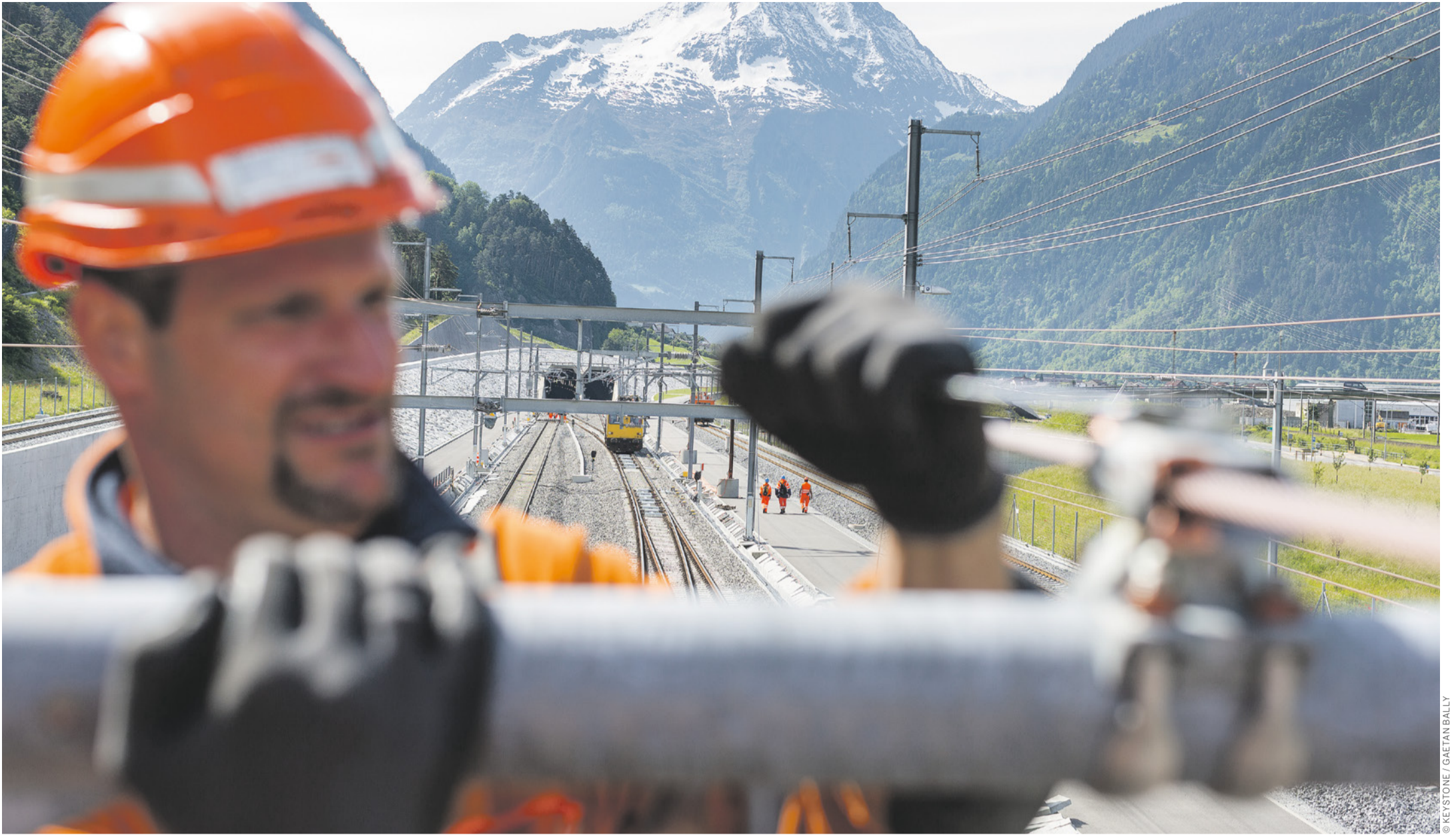
Beim Bereich Fahrleitung ist sicheres Arbeiten besonders wichtig.
