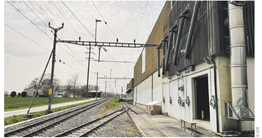
La zone de chargement des wagons à Bussy-Chardonney qui ne respecte pas les mesures de sécurité requises.
