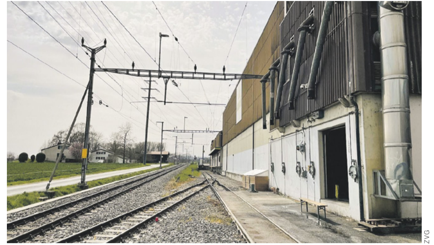
Der Waggonverladebereich des Landi-Sammelzentrums in Bussy-Chardonney, der die geltenden Sicherheitsvorschriften nicht einhält.
