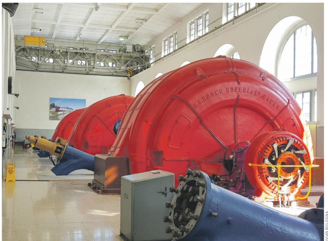
Dans l'usine du Châtelard, les générateurs rotatifs d'origine font le lien avec le réseau électrique CFF en courant ferroviaire 16,7 Hz depuis près de 100 ans.
