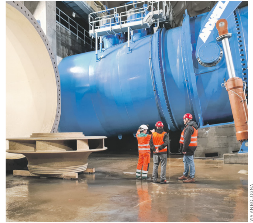
Der Besuch endet vor einer der Röhren, die einen Durchmesser von sieben Metern haben und die Seen Emosson und Vieux-Emosson verbinden.
