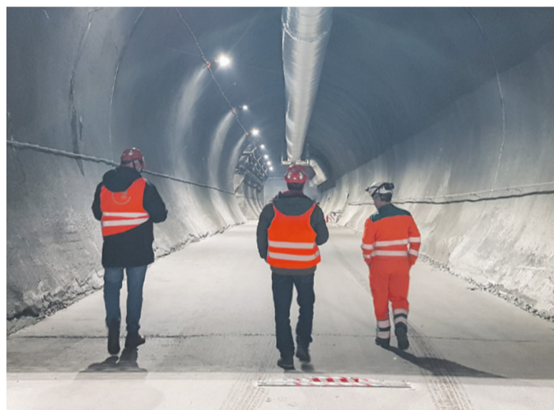
Die Anlage Nant de Drance ist tief in den Berg gebaut und von Stollen durchzogen. Ein echtes Labyrinth.
