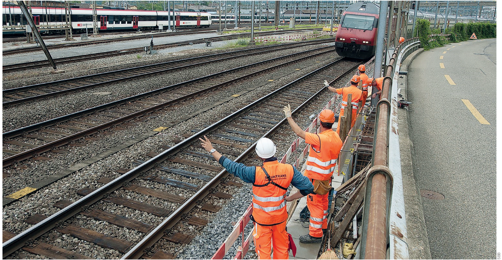
Die rund 800 Mitarbeitenden der Securitrans sind in den Bereichen Objektschutz und Baustellensicherheit (Bild) tätig, sowie als Triebfahrzeugführer.
