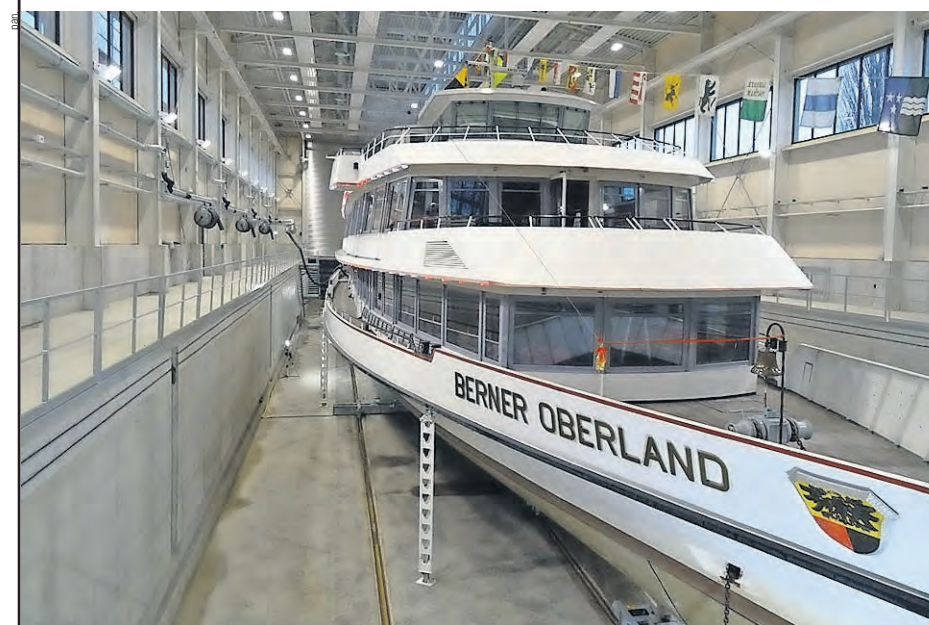
87 Meter lang, 24 Meter breit und 18 Meter hoch ist die neue Werfthalle der BLS im Lachen bei Thun, die neu auch über ein Trockendock verfügt. Das Geld für die Werfthalle stammt vom Kanton und den Gemeinden, womit die wichtige Funktion der Schifffahrt für die Region bestätigt wird. Am 24. und 25. März ist die Bevölkerung an «Tagen der offenen Werft» zur Beisichtigung eingeladen.
