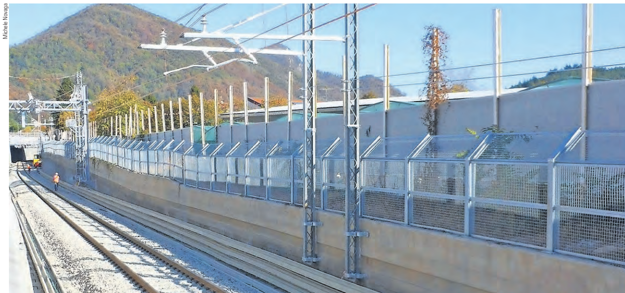
La linea ferroviaria interrata nel lato italiano della Ferrovia Mendrisio-Varese
