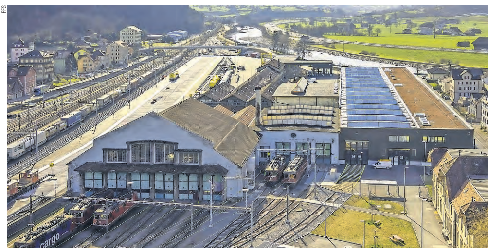
Il centro di intervento e manutenzione di Erstfeld, addossato alle storiche mura del deposito.
