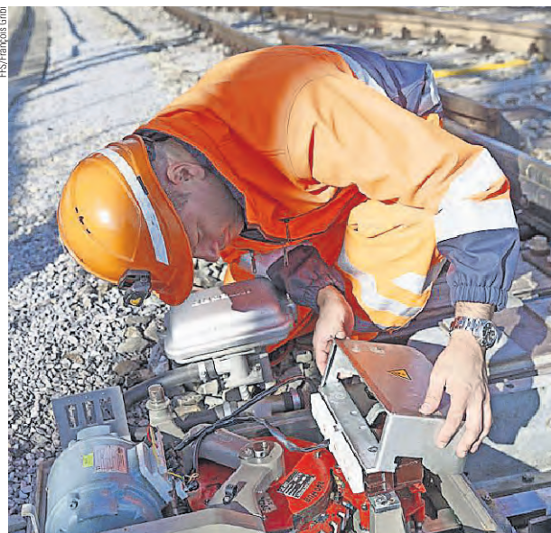
Un montatore di Infra IH impegnato con il motore di uno scambio.
