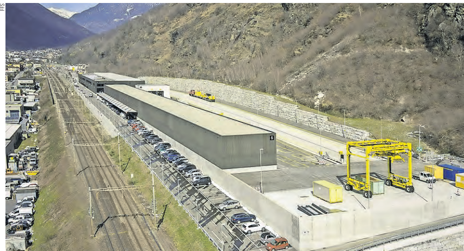
Il nuovo centro di manutenzione e di intervento di Biasca.
