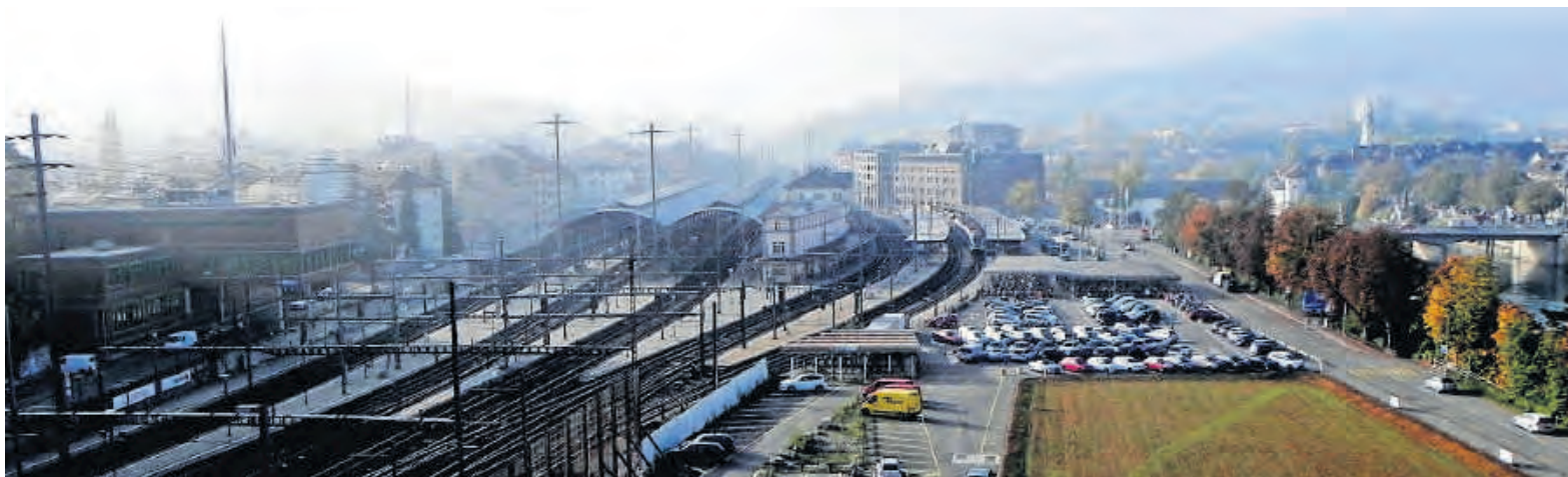
La terrazza della centrale d'esercizio offre un colpo d'occhio inedito verso sud, con la stazione e, sulla sinistra, la sede del vecchio impianto di sicurezza.
