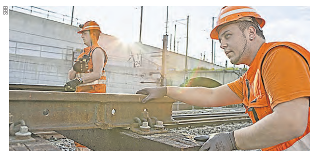
Know-how im eigenen Haus ist und bleibt im Gleisbau wichtig.
