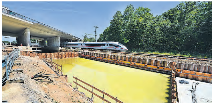
L'impegnativo cantiere per la circonvallazione di Rastatt.
