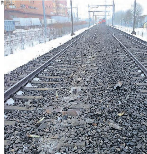
Am 16. Februar 2013, kurz vor 1 Uhr 30, führte dieser Schienenbruch bei Schwerzenbach zur Entgleisung einer Nacht-S-Bahn. Die 125 Passagiere blieben unverletzt.
