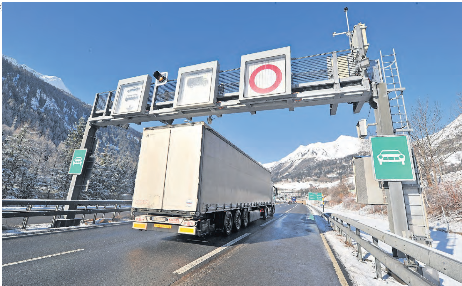
Il transito dei mezzi pesanti attraverso l'arco alpino deve essere regolamentato e moderato, oltre che controllato (qui un autocarro all'esame del portale termico di Airolò).
